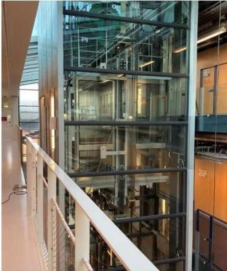
Ascensore utilizzato per le misurazione: KONE ascensore di trazione con ventilazione attiva
